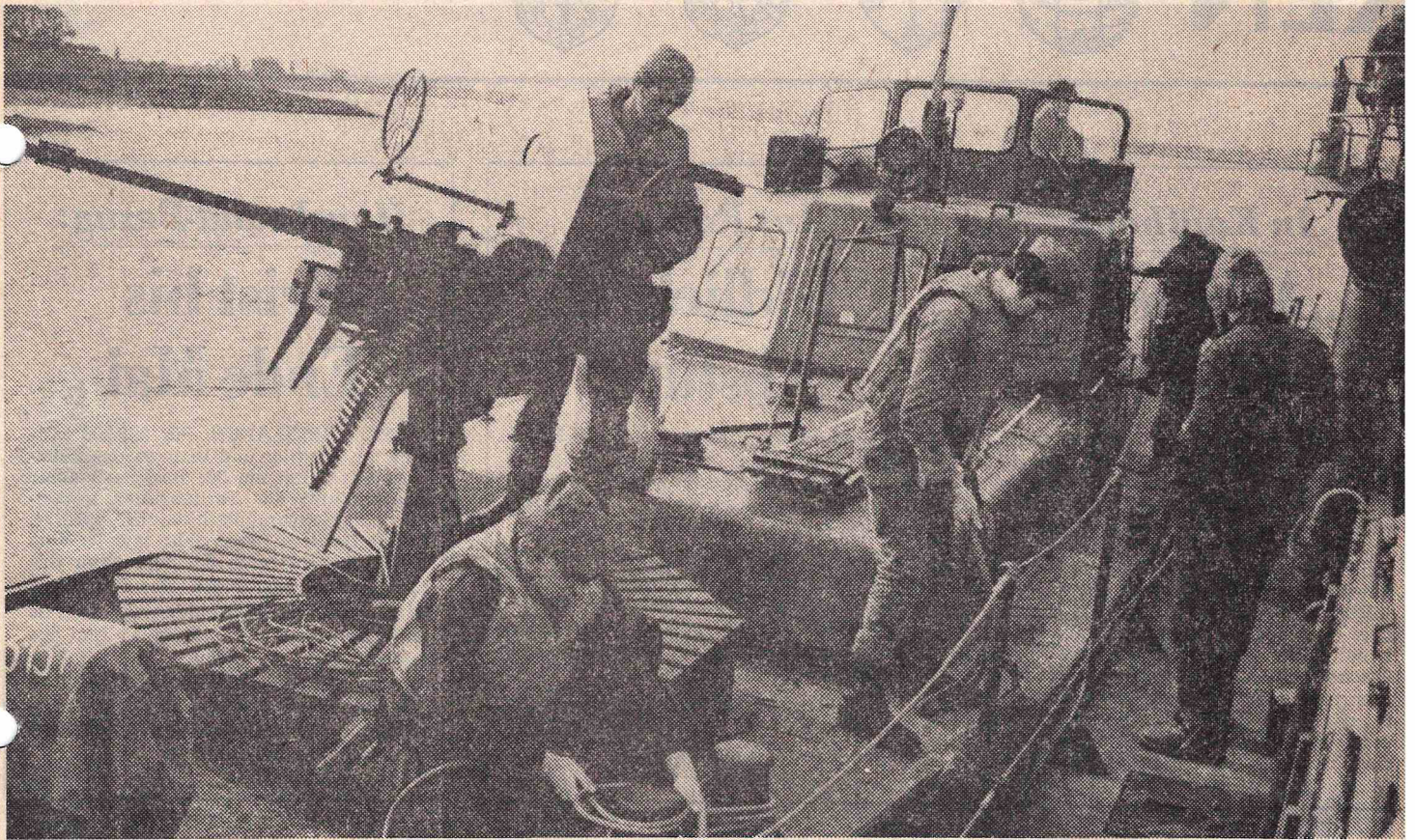
DAS SICHERUNGSBOOT hat am Orsoyer Rheinufer angelegt. Sofort beginnen die Soldaten — je nach Aufgabenverteilung — mit der Verankerung bzw. Sicherungsarbeit.
