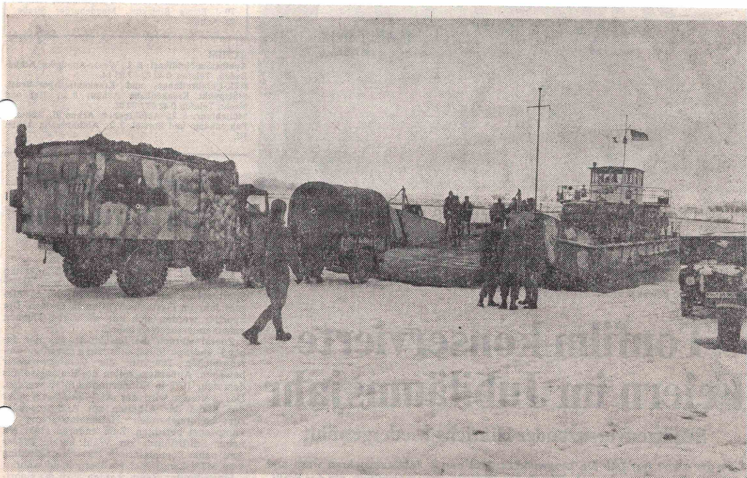
Unter erschwerten Bedingungen bei extremer Schneelage und eisigem Wind setzte die Flußpionierkompanie 831 gestern an der Übergangsstelle Groß Eißel rund 100 Radfahrzeuge und 300 Soldaten des Feldartilleriebataillons 111 aus Oldenburg über die Weser.
